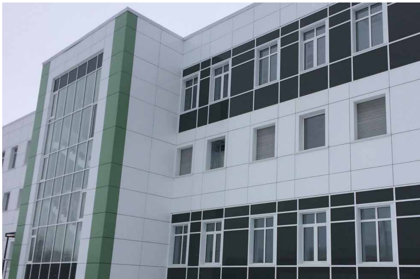
Здание лабораторного комплекса по контролю качества лекарственных средств в г. Ярославле
